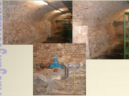
Zustand der Wand vor der Maßnahme
