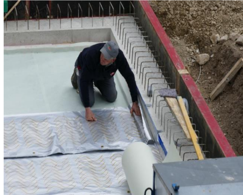
Gasdichter Anschluss an Betonteile
