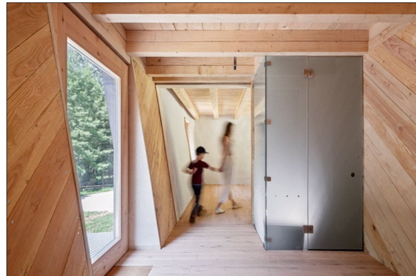
Technikmodul mit aussteifender Schalung
